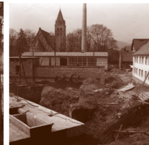
Erweiterungen im Bau, um 1962 (Foto: Stiftung Dome und Schlösser).
