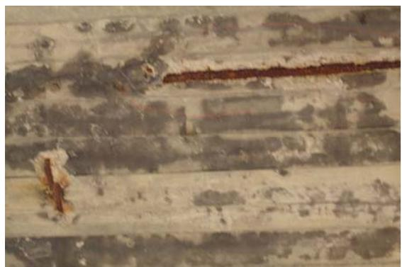
Bild 1.4 Frei liegende, korrodierte Bewehrung
