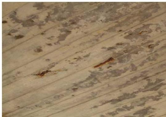
Bild 1.3 Betonabplatzungen
