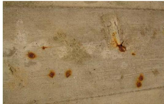
Bild 1.2 Rostflecken, Betonablösung
