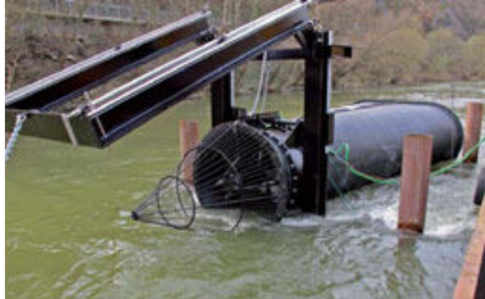
Bild 3 Axiale Flusswasserturbine mit Schutzrechen, Einlaufdüse und Austrittsdiffusor während der Installation im Fluss [3]
