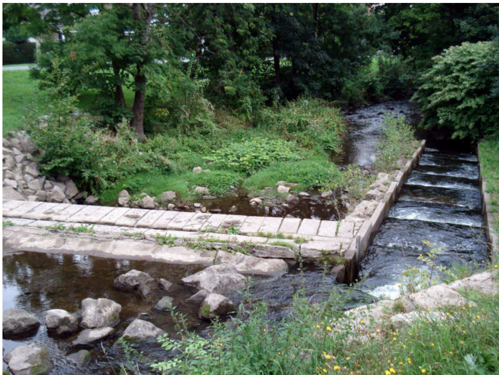
Abbildung 6.5: Blick von oben auf einen in der Holtemme zur Überbrückung des Querbauwerks H7 errichteten Schlitzpass.
