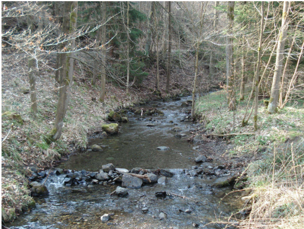
Abbildung 6.1: Ein Sohlabsturz mit geringer Höhe im Oberlauf der Holtemme.
