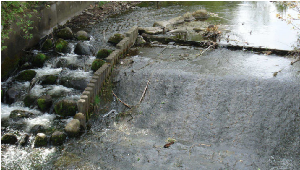
Abbildung 2.4: Der Rauhgerinne-Beckenpass Holtemme H6 (auf der linken Seite, auf der rechten Seite ist das ursprüngliche Querbauwerk erhalten geblieben).
