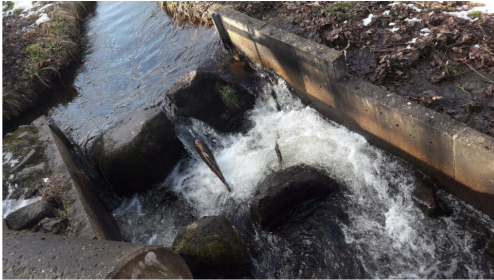
Abbildung 2.5: Durch die Platzierung von Felsen in einem technischen Fischaufstieg (hier: H4 in der Holtemme) geschaffene strömungsberuhigte Ruhezonen. Ebenfalls im Bild zu sehen ist eine durch den Wildfisch- und Gewässerschutzverein installierte Bachforelle aus Aluminium, die den Fischaufstieg als solchen kenntlich machen soll.
