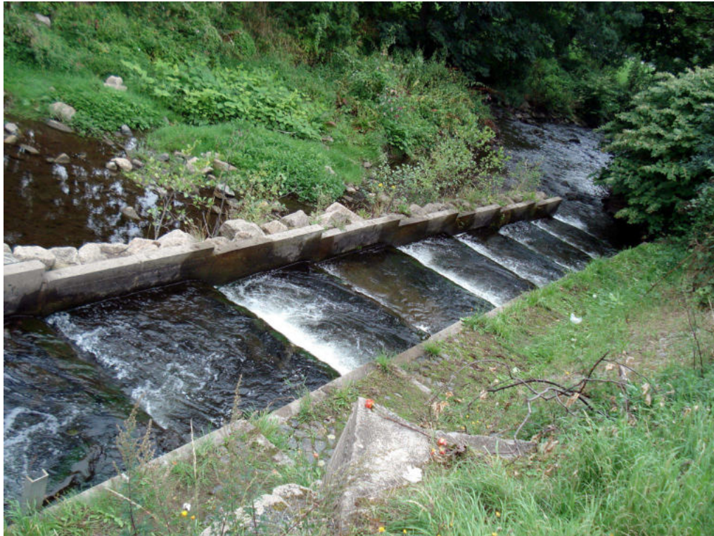
Abbildung 6.6: Blick von oben auf einen in der Holtemme zur Überbrückung des Querbauwerks H7 errichteten Schlitzpass.
